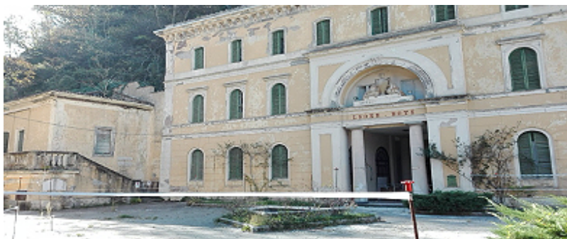
Antigo edifício do Comando da FEB em Porreta Terme, 01/11/2016.
